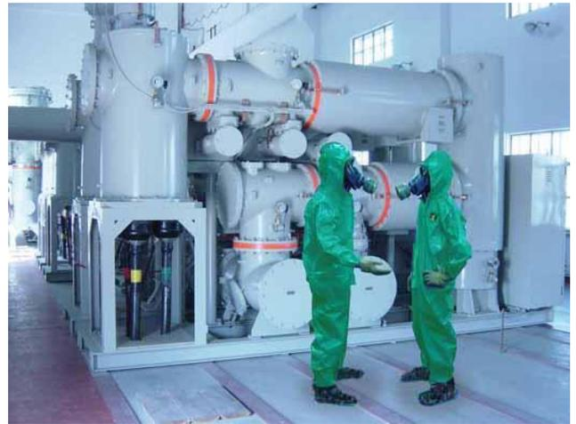
SF6 专用防护装备 (Winfoss-G1) 是 WINFOSS 公司专为从事 SF6 电气设备安装、调试、检修、维护的人员设计的。是确保人身免受有毒气体以及腐蚀性物质侵害的有力措施，是电力系统急需的防护用品。其中的 SF6 专用防毒面具能确保上述人员的呼吸器官、眼睛及面部皮肤免受 SF6 高压电器中的分解产物氢酸、二氧化硫、低氟化物等有毒、有害、腐蚀性物质的伤害，达到有效地防护目的。完全满足国家电力行业标准 DL/T639-2016 所规定要求。
